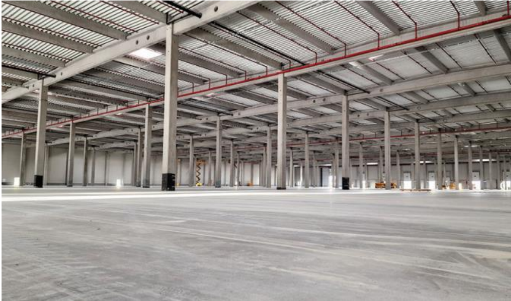
EMAG logisztika nagytáblás ipari padlója High Grade szálerősítéssel
